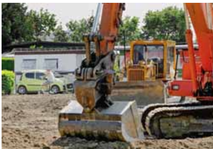
Bauarbeiten in der Hochsaison: Schwere Maschinen vor den Wohnwagen des Campings in Sutz-Lattrigen. Bild: Olivier Gresset
